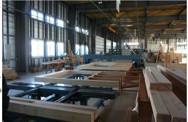
丸十木材プレフレーミング工場
